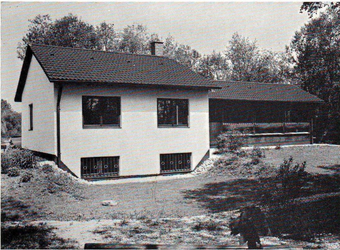
Bienenhof Aham (Gesamtansicht)
